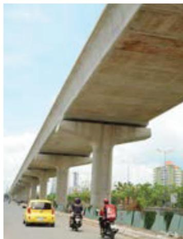
Kỹ thuật bê-tông Dự ứng lực căng sau áp dụng cho cấu kiện cầu có nhịp lớn hoặc bản dầm của móng cầu, bản đường trên cao.
