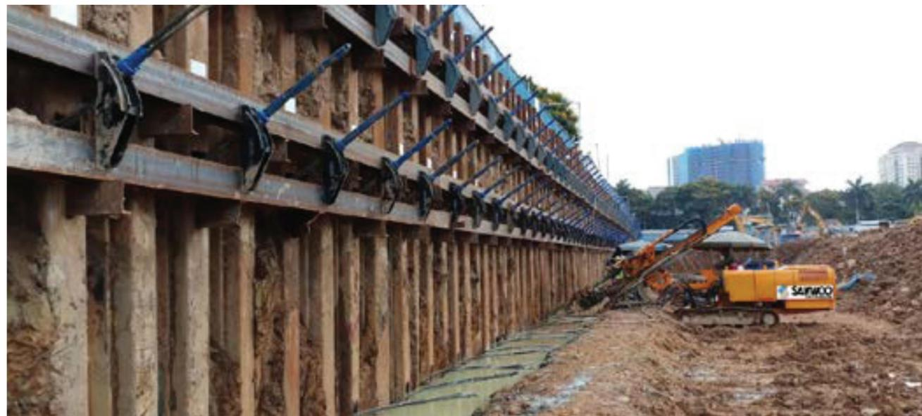
Kỹ thuật neo đất, neo đá là một giải pháp an toàn và hiệu quả với hệ neo tạm thời và hệ neo vĩnh cửu đã và đang được ứng dụng rộng rãi trên toàn thế giới giúp tiết kiệm chi phí thi công và rút ngắn tiến độ thi công phần ngầm của công trình.
